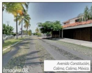
**Empedrado permeable con huellas de rodadura vehicular**
