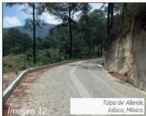
**Empedrado ahogado en concreto con huellas de rodamiento de concreto**
