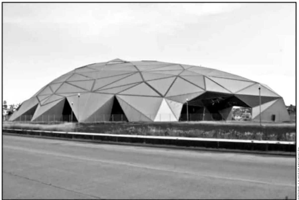
EL PROYECTO PLANTEABA LA CONSTRUCCIÓN DE UNA CLÍNICA MUNICIPAL JUNTO AL COMPLEJO DEPORTIVO BICENTENARIO, AL NORTE DE LA CIUDAD.
