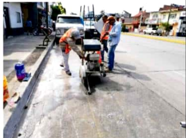
ZAMORA, MICH.- Trabajos de rehabilitación integral de la red de agua potable, se iniciaron en la colonia Ramírez de esta ciudad.
