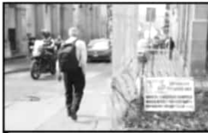
PREVEN CONCLUIR LAS OBRAS A TIEMPO, PARA EVITAR MAYORES MOLESTIAS A PEATONES Y CONDUCTORES.
