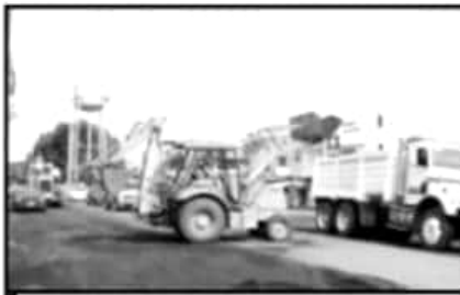
EN DIVERSAS PARTES DE LA CIUDAD SE PUEDEN APRECIAR MÁQUINAS Y CAMIONES EN LABORES DE BACHEO.
