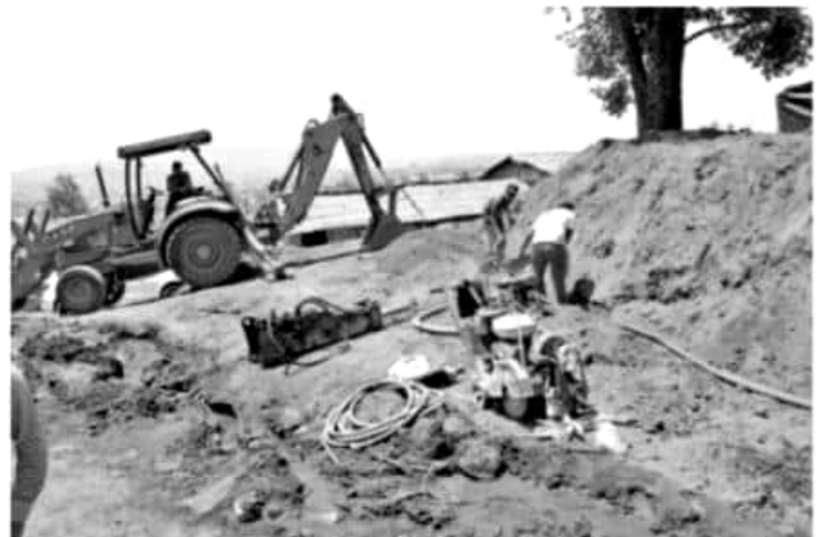
URUAPAN MICH.- La obra se pretende terminar a finales del mes de mayo
