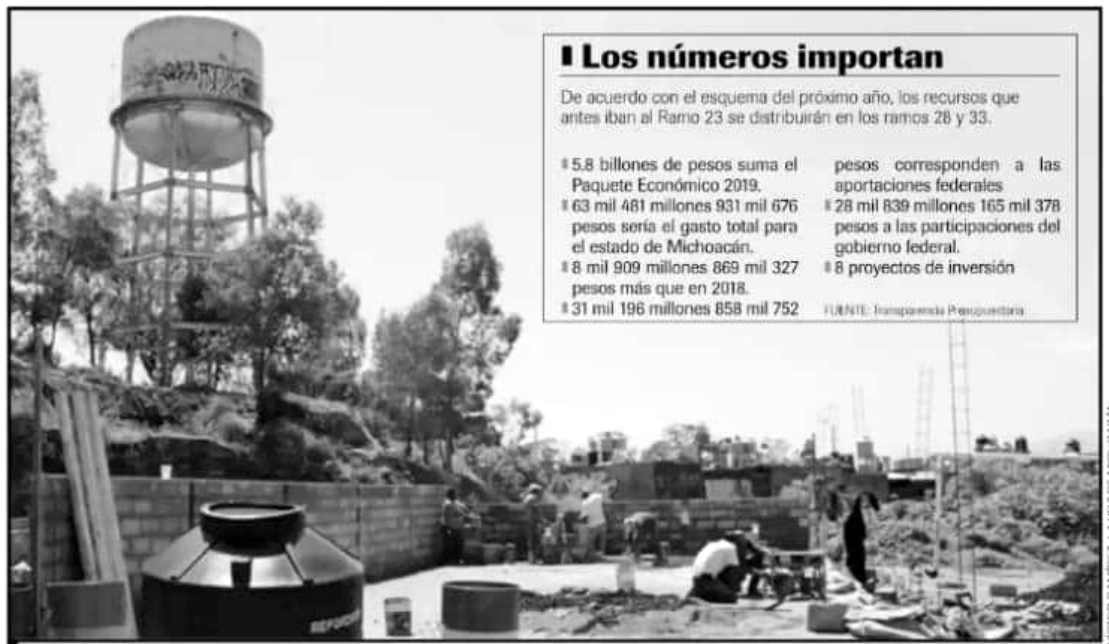
LA UNIDAD DE MEDICINA FAMILIAR EN EL MUNICIPIO DE TARIMBARO APARECE COMO UNA DE LAS 8 OBRAS PRIORITARIAS DEL GOBIERNO FEDERAL EN EL ESTADO.
