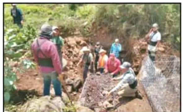
EL AYUNTAMIENTO CONSTRUYÓ REPRESAS Y FRENO EN VARIOS PUNTOS DEL CERRO.
