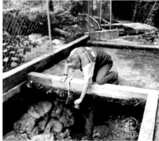
URUAPAN, MICH. Capasu, continúa realizando la aplicación diaria de 600 litros de hipoclorito de sodio en depósitos y cárcamos de bombeo para garantizar agua para uso y consumo humano
