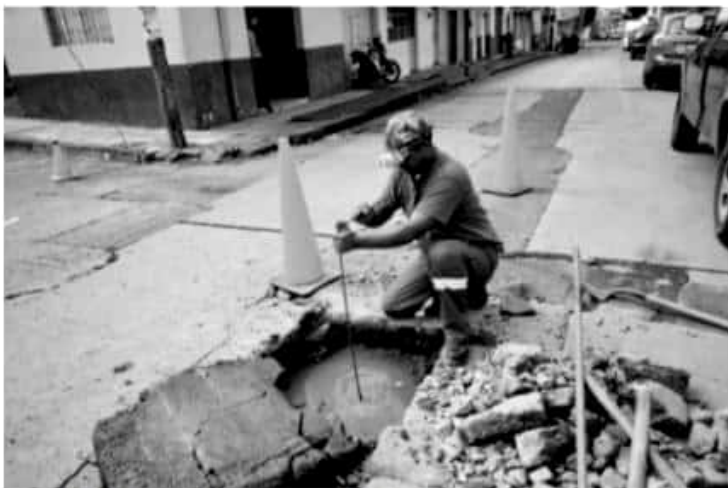
URUAPAN MICH.- De acuerdo con el director general de Capasu, Miguel Ángel Paredes Melgoza, una vez localizado el pozo de visita, se observó que tenía un taponamiento en la tubería principal que baja hacia la Calzada Benito Juárez
