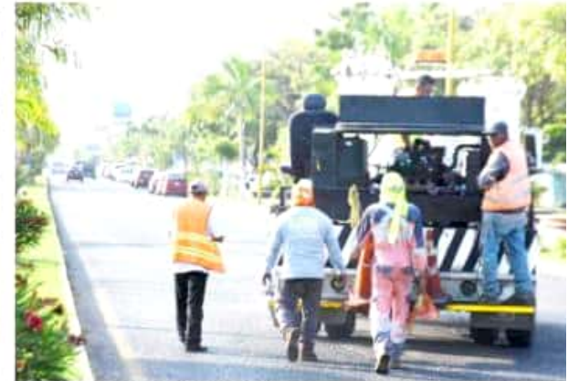
CD. LÁZARO CÁRDENAS, MICH.- La Secretaría de Obras Públicas Municipales retomó los trabajos de balizamiento de las principales avenidas del municipio.
