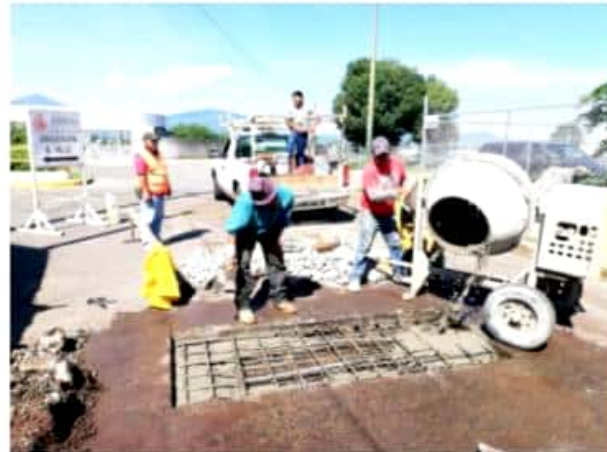
ZAMORA, MICH.- Miguel Aviña García, titular de la Dirección de Obras Públicas, informó que se repararon 2.5 metros cuadrados de pavimento en el Circuito Vial Galeana.
