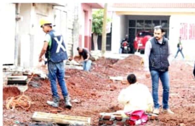
LOS REYES, MICH.- Positivo avance registra la pavimentación de la calle Nueva Constitución, en la colonia Emiliano Zapata.
