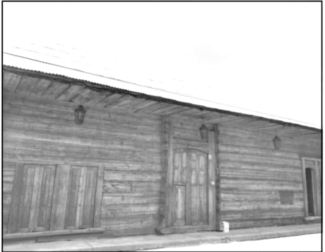
Más de 10 millones de pesos es el monto destinado a la rehabilitación de trojes, mejoramiento de imagen urbana e instalación de ecotecnias en las zonas Lacustre y Meseta purépecha.
