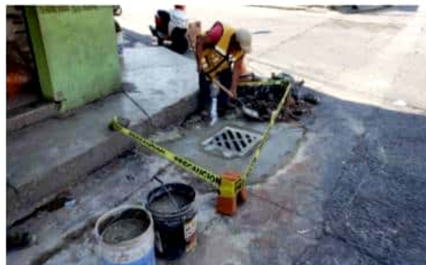
ZAMORA, MICH.- Las brigadas del Sapaz intensifican los trabajos de limpieza en alcantarillas y la red de drenes, para evitar encharcamientos ante las fuertes lluvias.
