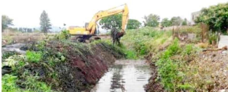
APATZINGÁN, MICH.- Trabajos de desazolve de canales de riego y rehabilitación de caminos rurales, destacan entre los apoyos de la Sedrua para favorecer a los productores de esta y otras regiones.
