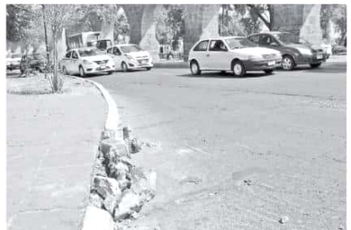
Más que una mala proyección de obras viales, ha existido una carencia de atención y mantenimiento. LAZARO MORALES
