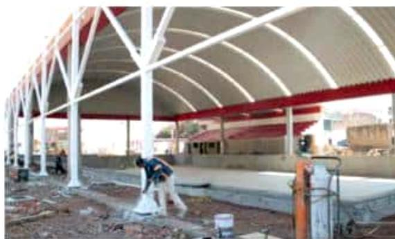
Además, el inmueble contará con una estructura de acero perimetral, una cubierta de poliuretano con una altura de 6 a 13 metros y otra más de lámina acanalada sobre el área de calentamiento y el acceso a
