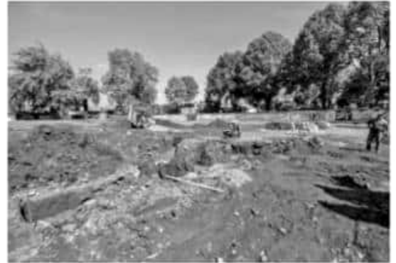
URUAPAN, MICH.- Mediante recorrido por la Unidad Deportiva "Hermanos López Rayón", el alcalde Víctor Manuel Manríquez González supervisó la primera etapa de las obras de remodelación del Estadio y la construcción de la Alberca Semi-Olimpica. En ambas acciones se invierten 10 millones de pesos.
