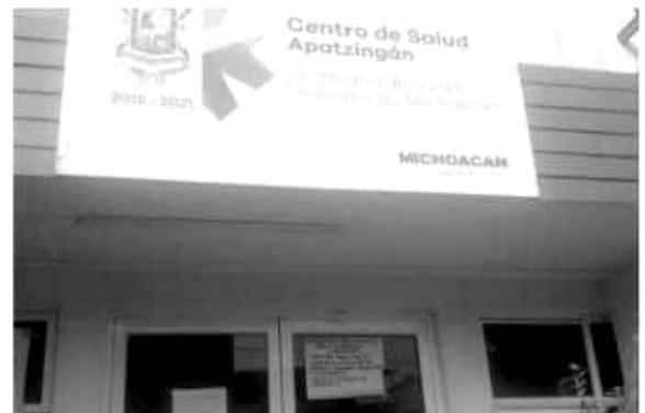
Por daños en el cableado de energía eléctrica, se suspendieron actividades en el Centro de Salud Urbano de esta ciudad; se reanudarán el día de hoy.
