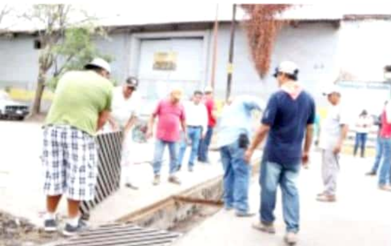
APATZINGÁN, MICH.- Personal de Servicios Municipales y Obras Públicas, realizan mantenimiento, reparación y desazolve de alcantarillas y limpieza de canales en zonas consideradas de riesgo, previo a la temporada de lluvias.
