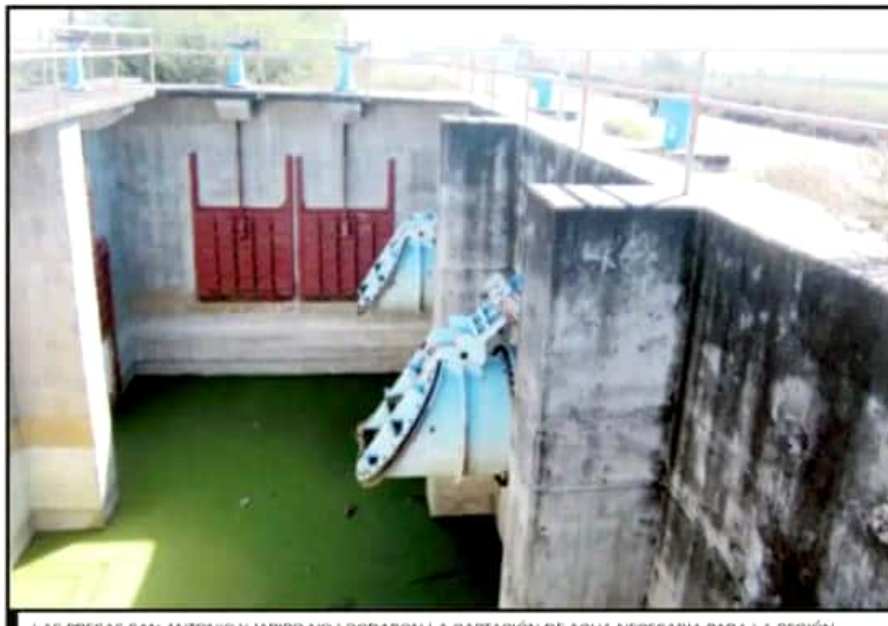
LAS PRESAS SAN ANTONIO Y JARIPO NO LOGRARON LA CAPTACIÓN DE AGUA NECESARIA PARA LA REGIÓN.
