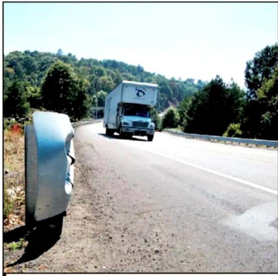
ADEMÁS DE LA INSEGURIDAD QUE SE VIVE EN LA AUTOPISTA SIGLO XXI TAMBIÉN HAY VARIOS DESPERFECTOS EN LA VÍA.
