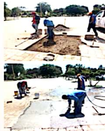
CD. LÁZARO CÁRDENAS, MICH.- La Secretaría de Obras Públicas Municipales sigue efectuando una serie de trabajos en varios puntos del municipio, destacando la reparación del piso de la explanada municipal.
