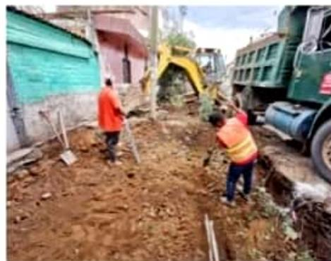
ZAMORA MICH.- Con el apoyo de maquinaria pesada se procede a la apertura del terreno a mejorar, para posteriormente efectuar la aplicación de materiales y compactación.
