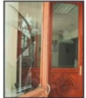
DESTRUCCIONES FUERON VARIAS.
