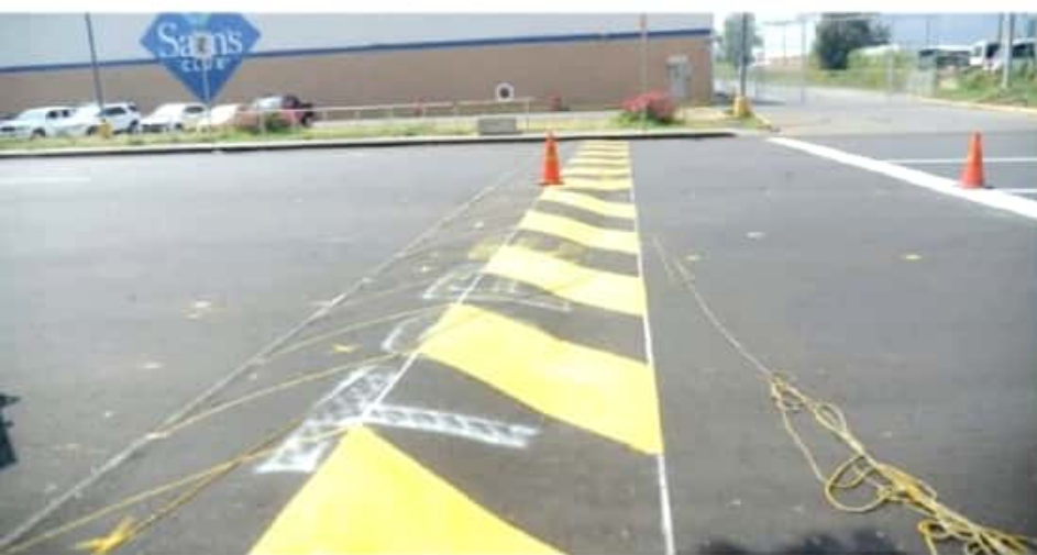
JACONA, MICH.- El gobierno municipal concluye el proyecto de rehabilitación de la Calzada Jacona-Zamora con el balizamiento, siendo esta obra una realidad.
