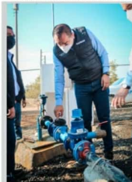
URUAPAN, MICH.- El titular de la Capasu, Luis Manuel Magaña Magaña, supervisó el avance que se tiene en el equipamiento del pozo profundo en San Martín Buenos Aires.
