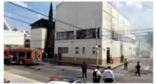
Daños. El fuego se acrecentó y calcinó varios muebles. /RED 113
