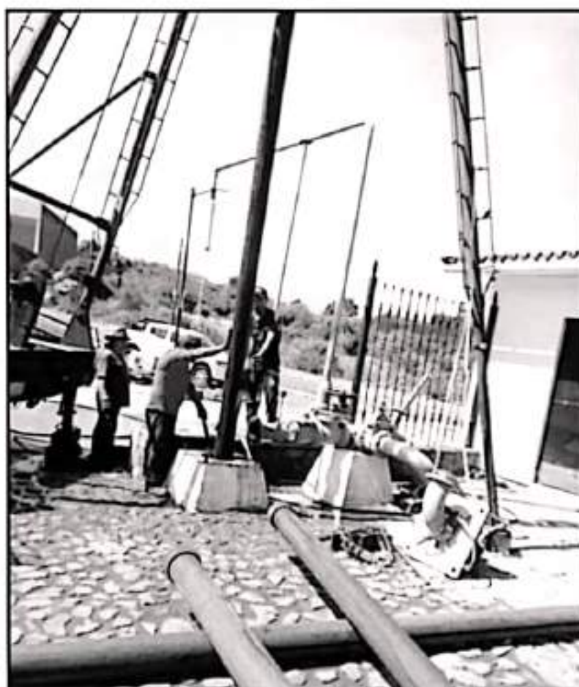
AUTORIDADES MUNICIPALES ASIGURAN QUE CON ESTA REPARACIÓN SE DUPLICARÁ EL SUMINISTRO DE AGUA POTABLE.
