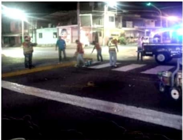
CD. LÁZARO CÁRDENAS, MICH.- La Delegación de Tránsito del Estado en coordinación con el gobierno municipal, llevaron a cabo el balizamiento de un tramo de la avenida Belisario Domínguez.
