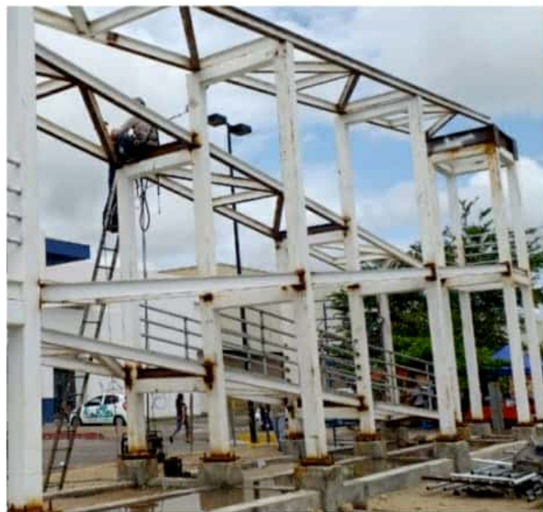
CD. LÁZARO CÁRDENAS, MICH.- El puente peatonal de Las Palmas, el cual ubicado a la altura de la Plaza Las Américas, presenta un 85 por ciento de avance en la construcción
