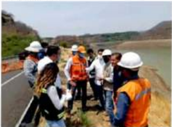
Personal de la Autopista Siglo XXI y de PC Estatal, en el momento de evaluar el daño a la carpeta asfáltica, que determinó finalmente el cierre temporal, de por lo menos 15 días, del tramo Santa Casilda-Entronque Cuatro Caminos.
