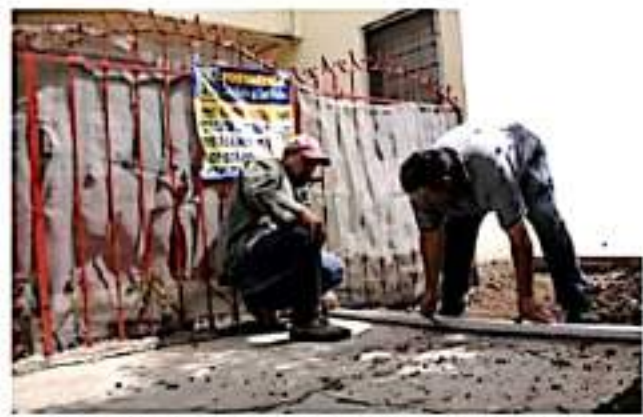
ZAMORA, MICH.- Los trabajos consisten en eliminar puntos de peligro para que puedan transitar libremente sin sufrir algún accidente.
