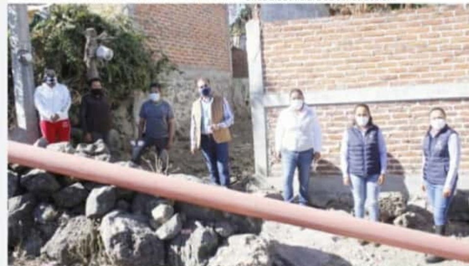
IXTLÁN DE LOS HERVORES, MICH.- El edil de Ixtlán se comprometió a iniciar lo más pronto posible los trabajos de instalación de esta tubería.
