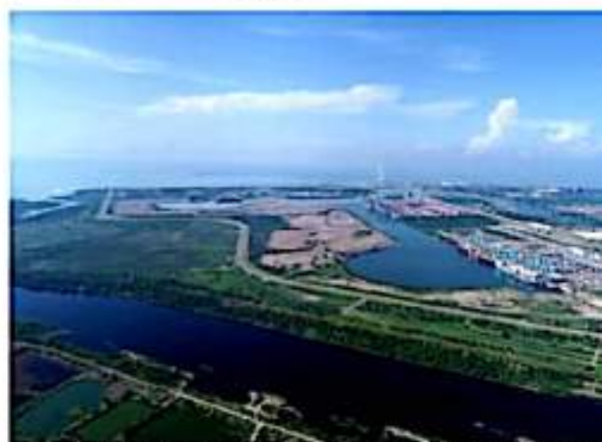
CD. LÁZARO CÁRDENAS, MICH.- La API busca edificar un muelle para cabotaje, en el denominado "vaso de burras" donde estaba una tercera desembocadura del río Balsas.
