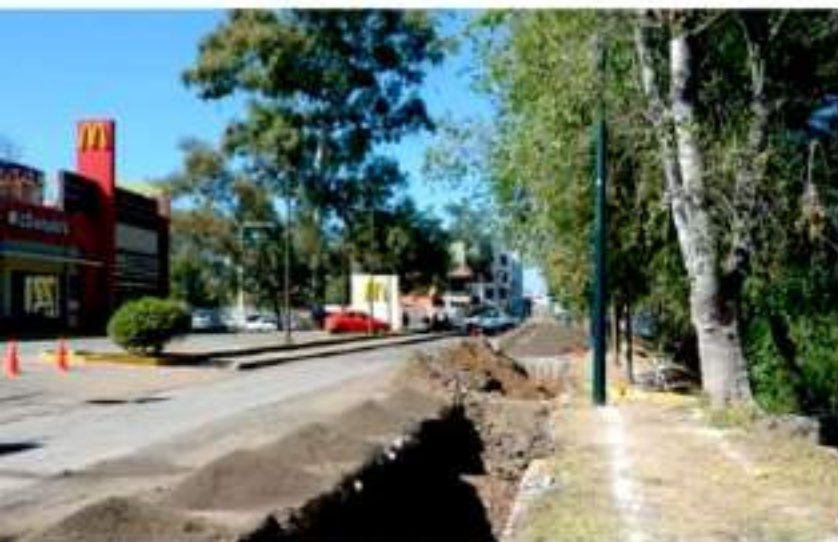
MORELIA, MICH.- Inició la obra para aplicación de carpeta asfáltica y accesos universales en la Calzada Ventura Puente de Morelia.
