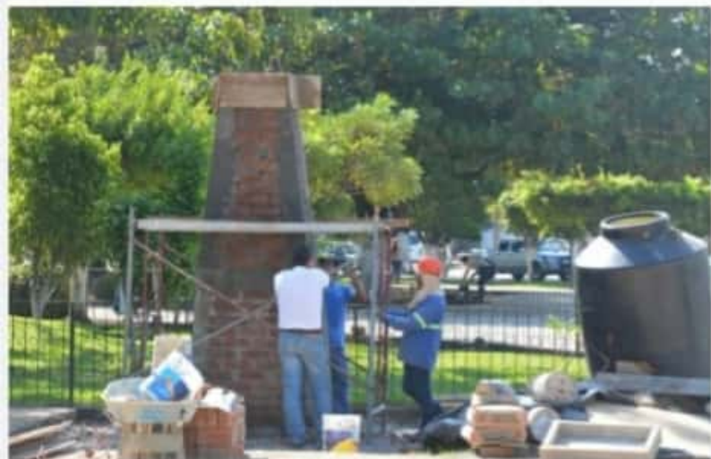
CD. LÁZARO CÁRDENAS, MICH.- En el jardín de la explanada municipal se construye un nuevo
