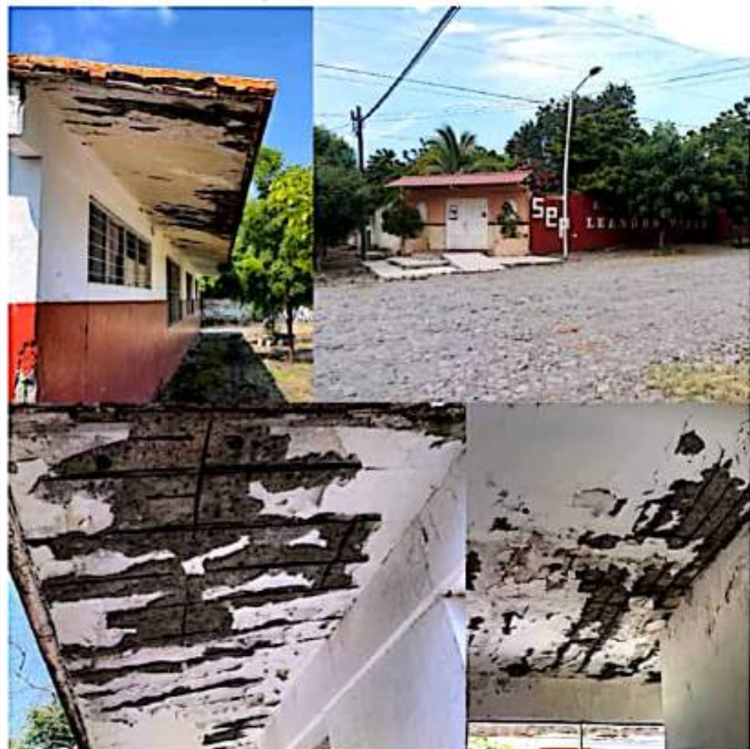
APATZINGÁN, MICH.- Así quedó de manifiesto durante una reunión de padres de familia de la Escuela Primaria "Leandro Valle", ubicada en la colonia "José Ortiz de Domínguez", cuya área de sanitarios ocupa de la reconstrucción total.
