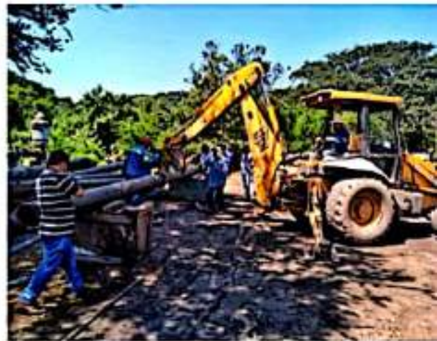
CD. LÁZARO CÁRDENAS, MICH.- Capalac presenta un gran avance en los trabajos de rehabilitación de la tubería que fue dañada por las lluvias en la
