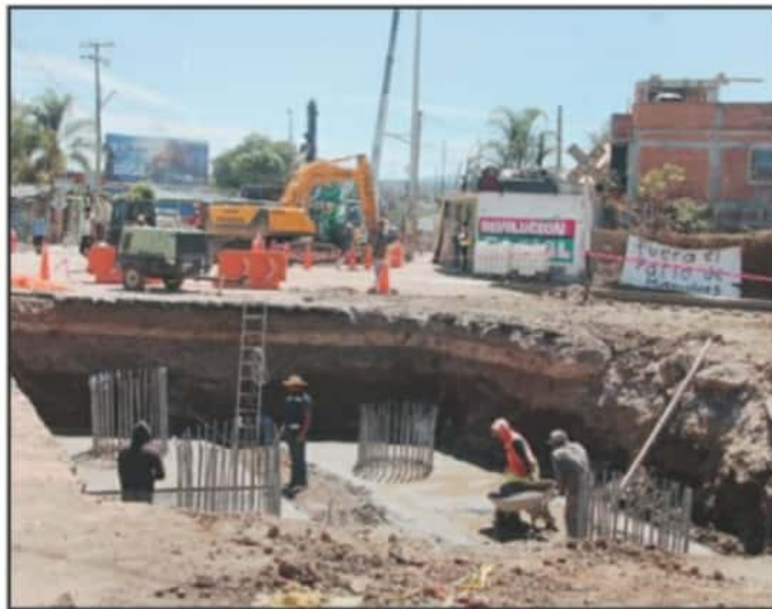
LOS ATRASOS EN LAS OBRAS EN LA AVENIDA SIERVO DE LA NACIÓN, GNERAN DESCONTENTO EN LOS CIUDADANOS.
