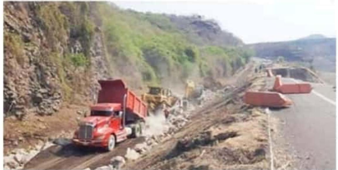
Con maquinaria pesada se realizan los trabajos para habilitar un paso provisional, a un costado del tramo dañado de la autopista Siglo XXI.
