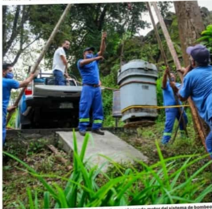
URUAPAN, MICH.- Con trabajo manual, debió retirarse el pesado motor del sistema de bombeo de agua "El Milagro", en el manantial Gandarillas.
