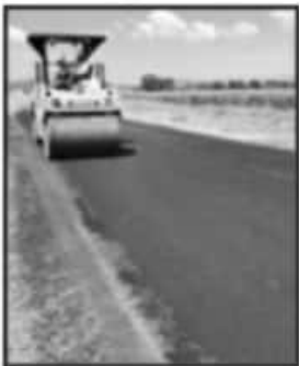
DIERON INICIO LOS TRABAJOS DE RE-ENCARPETAMIENTO EN LA PIEDAD.
