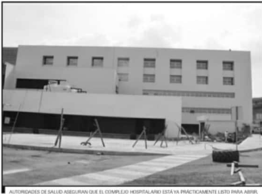
AUTORIDADES DE SALUD ASEGURAN QUE EL COMPLEJO HOSPITALARIO ESTÁ YA PRÁCTICAMENTE LISTO PARA ABRIR
