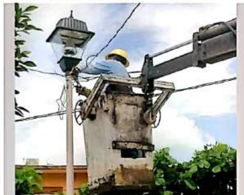
CD. LÁZARO CÁRDENAS, MICH.- El Departamento de Alumbrado Público, llevó a cabo la colocación
