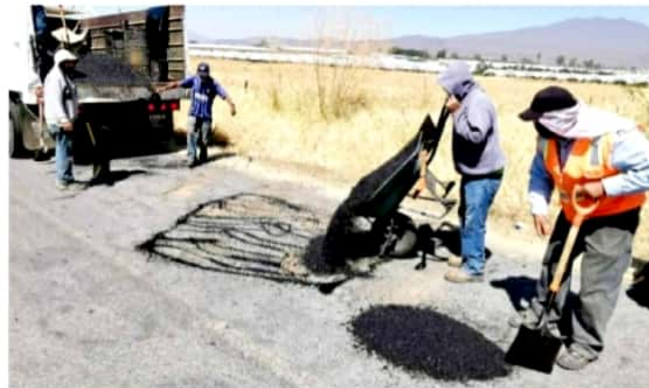
ZAMORA, MICH.- La cuadrilla de bacheo procedió a aplicar un promedio de 5 metros cúbicos de carpeta asfáltica en caliente y 150 litros de emulsión.
