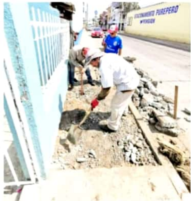
ZAMORA, MICH.- El personal encargado de efectuar las maniobras, procedió a la demolición de la parte afectada.
