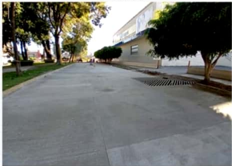
URUAPAN, MICH.- En el transcurso de la próxima semana se reabrirá a la circulación vehicular el tramo modernizado de la avenida Paseo Gral. Lázaro Cárdenas del Río, con una longitud de casi un kilómetro.
