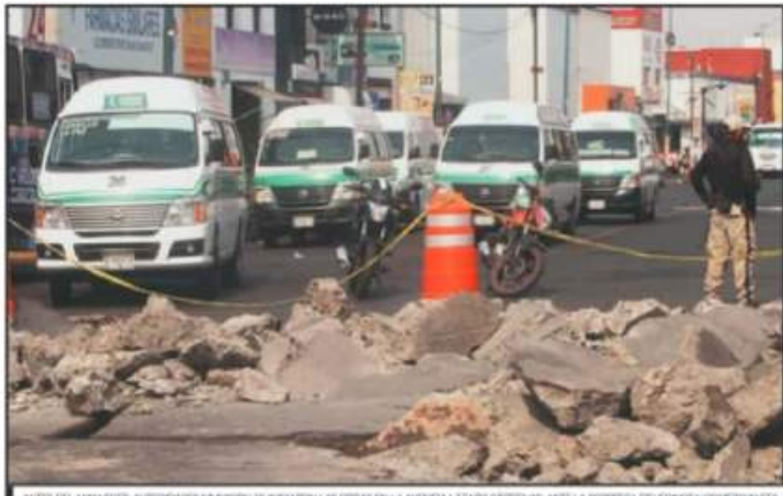
ANTES DEL AMANECER, AUTORIDADES MUNICIPALES INICIARON LAS OBRAS EN LA AVENIDA LÁZARO CÁRDENAS ANTE LA SORPRESA DE VECINOS Y COMERCIANTES.
