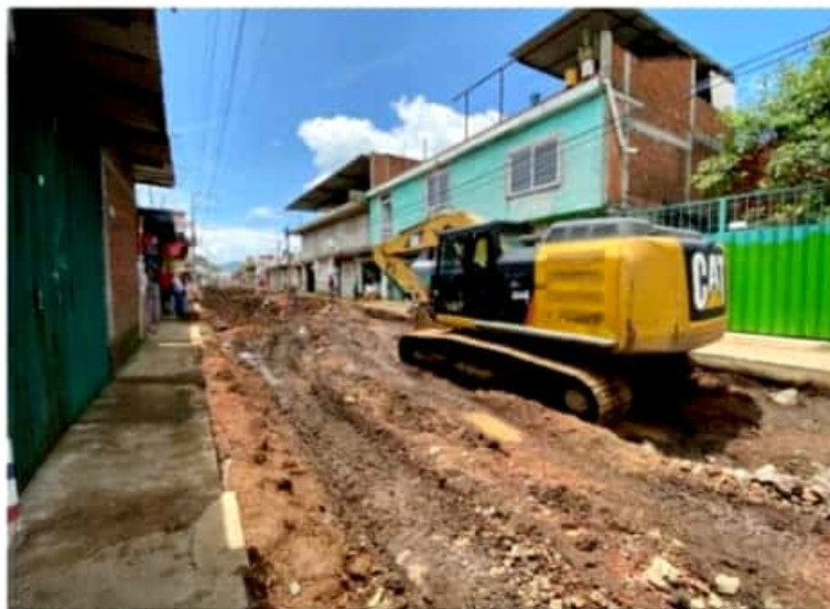
URUAPAN, MICH.- Con la construcción del colector pluvial Antorcha-Constituyentes se da respuesta a una añeja demanda.
