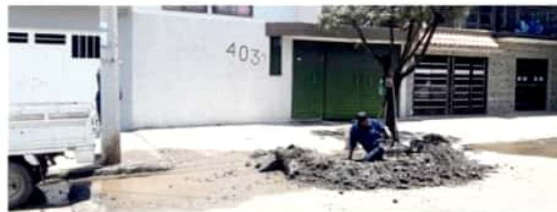
ZAMORA, MICH.- Personal del área operativa señaló que desde la semana pasada los fontaneros del Sapaz iniciaron con los trabajos de excavación.
