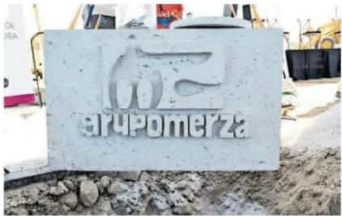
Se llevó a cabo la colocación de la primera piedra del Centro Logístico para Centro Occidente / CORTESÍA SIEDCO
