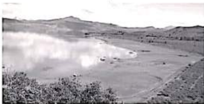
La Presa del Bosque fue construida en 1954 por la CFE y la Conagua, forma parte del Sistema Cuzamáta, se encuentra a una altitud de 1,330 metros y su profundidad es aproximadamente de 40 metros.
