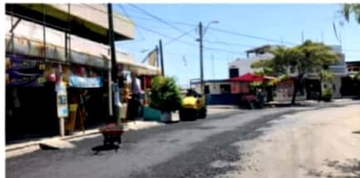
CD. LÁZARO CÁRDENAS, MICH.- La Secretaría de Obras Públicas Municipales, inició los trabajos de reencarpentamiento de la Avenida Belisario Domínguez, en el tramo del cruce con las avenidas Melchor Ocampo hasta Francisco Noyola.
