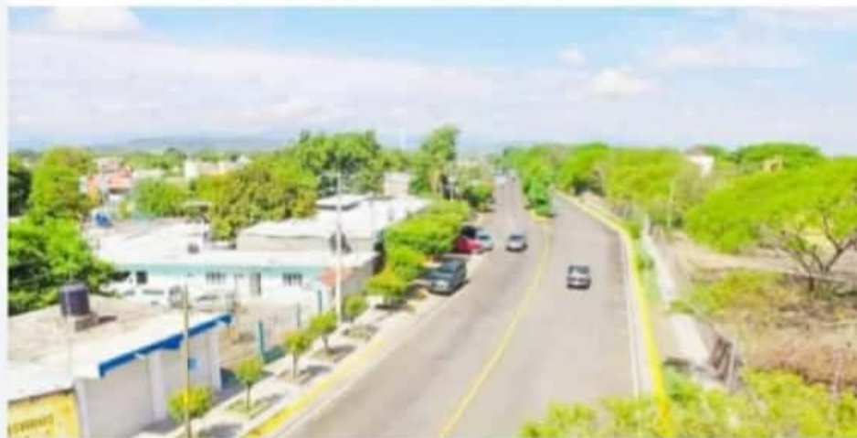
APATZINGÁN, MICH.- Juan Carlos Sánchez Pardo, expuso que las obras son pavimentaciones, drenajes, alumbrado público y rehabilitaciones.
