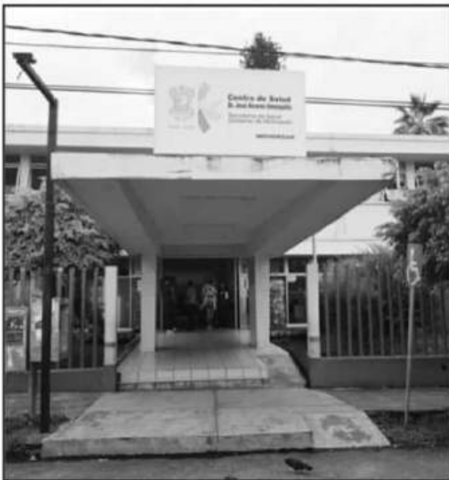
EL ACTUAL CENTRO DE SALUD CUMPLIÓ SU VIDA ÚTIL. LA PRÓXIMA SEMANA INICIARÁ SU DEMOLICIÓN
