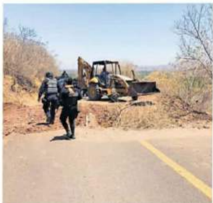
De acuerdo al riesgo que se advierte, se implementarán los protocolos de seguridad. | CORRIÓN SUR
