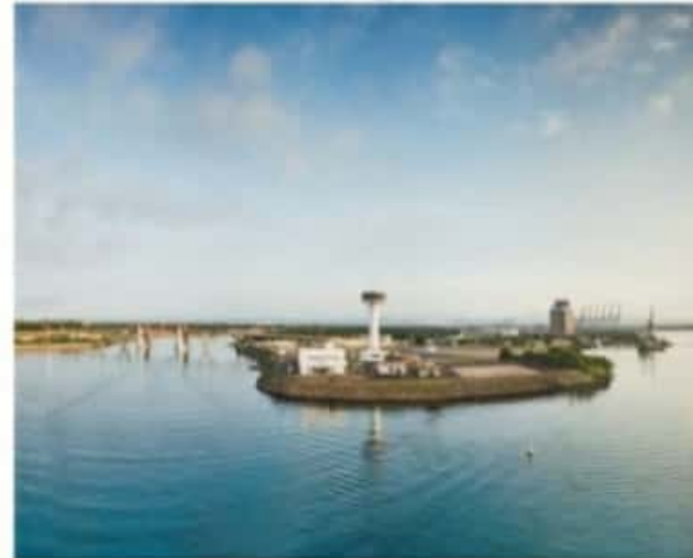
CD. LÁZARO CÁRDENAS, MICH.- La Auditoría Superior de la Federación, en su informe de revisión a la Cuenta Pública 2019, señala irregularidades en el proyecto de instalación de líneas subterráneas del Puerto de Lázaro Cárdenas, en concreto por la falta de su inclusión en el Programa Anual de Obra Pública y Servicios 2019 de la Apilac.
